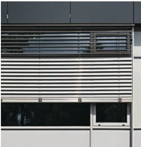
Abb. 25 Fenster mit außenliegendem Sonnenschutz, der hinterlüftet werden kann. Quelle: C. Moosmann
