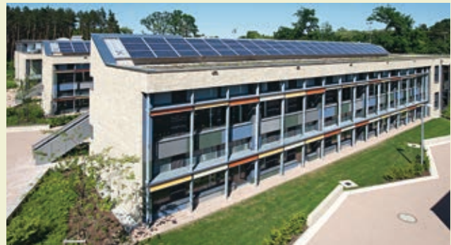
Abb. 27 Im Demonstrationsprojekt Hohen Neuendorf kommt natürliche und mechanische Belüftung zum Einsatz. Quelle: Ali Moshiri
