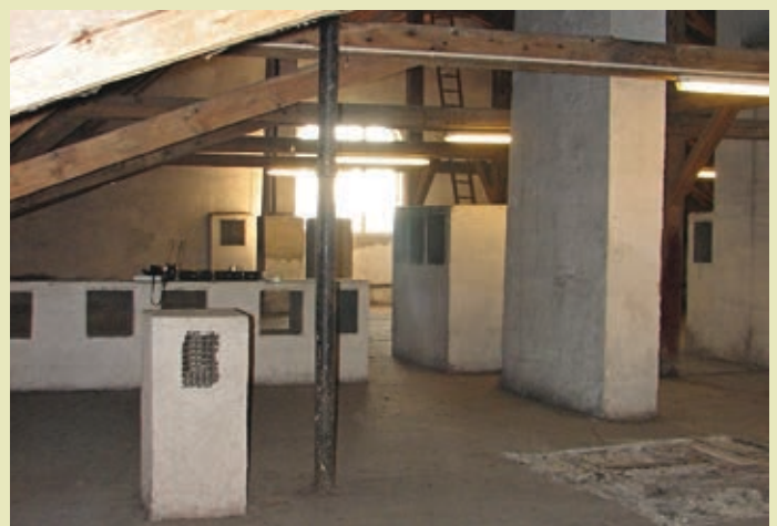
Abb. 16 Historische Abluftschächte auf dem Dachboden Quelle: Hochschule Augsburg, E2D, Bauklimatik, 2010
