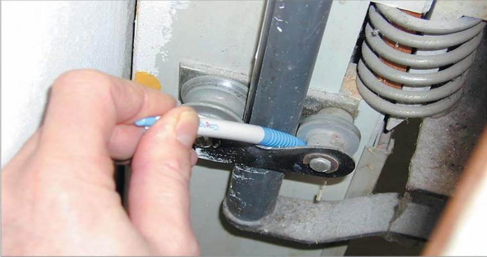
Foto 29: Schiebe-Tafel mit außenliegenden Führungsrollen
