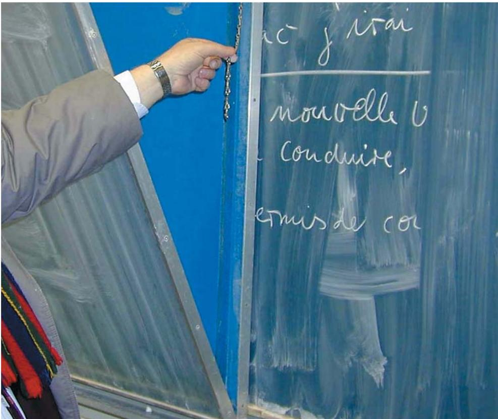
Foto 17: Klappflügel mit Wechselleineatur
